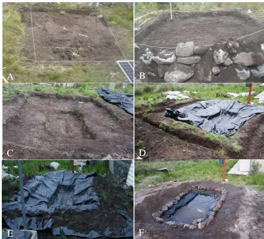
Figura 11. A) Limpieza y medición del terreno. B) Nivelación del terreno. C) Muestran las tres profundidades. D) Muestran las zanjas de 30 cm a los extremos donde se enterró el plástico. E) Cubrimiento de tierra. F) Abastecimiento de agua.
