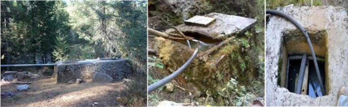
Figura 4. Se observa la forma en que están diseñados los registros (paredes completamente verticales)
