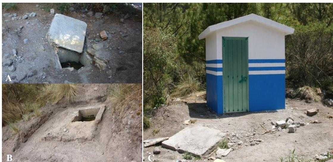
Figura 17. A) Indica como estaba diseñado el registro de agua antes de la construcción de casetas, B) Muestra donde se iba a construir la caseta, y C) Se puede observar el diseño de las casetas en Cañada Grande
